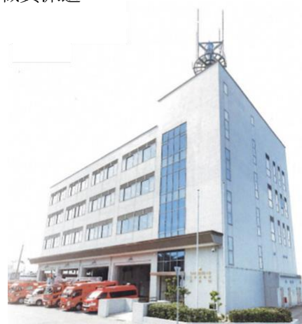
七尾鹿島消防本部庁舎5階に設置
