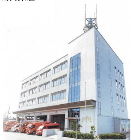
七尾鹿島消防本部庁舎5階に設置
