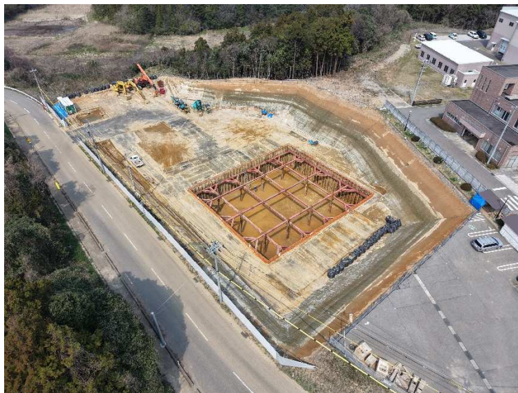
・建設地 北側（令和7年4月2日撮影）
