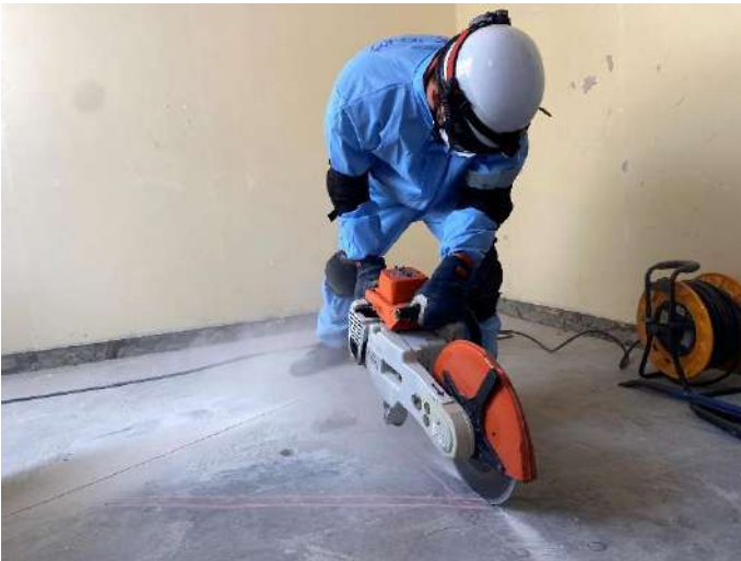
鉄筋コンクリート等を破壊する訓練
